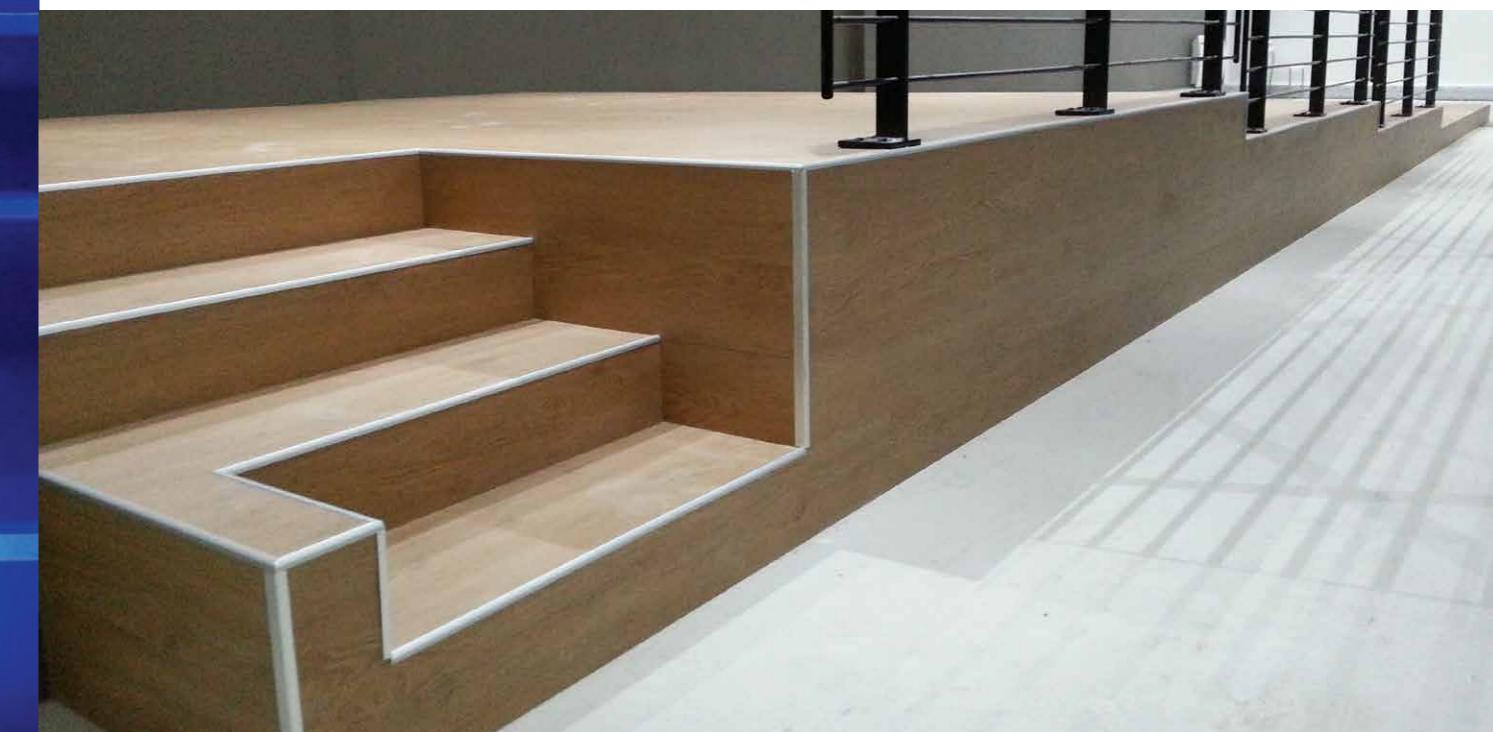
Le tribune sono progettate e calcolate, tenendo conto del luogo in cui saranno installate. Sono dimensionate per un sovraccarico variabile da 4,0 a 6,0 kN/m<sup>2</sup> oltre al peso proprio. Le normative utilizzate che riguardano il calcolo strutturale e le azioni sismiche sono le seguenti:
